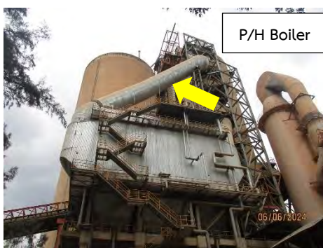
รูปที่ 2-3 ท่อนำลมร้อนทิ้งจาก P/H Boiler และ Clinker Cooler โรงงาน 2 (สายการผลิตที่ 3)
