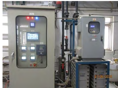
รูปที่ 2-39 ระบบ EDI (Electrodeionization)
