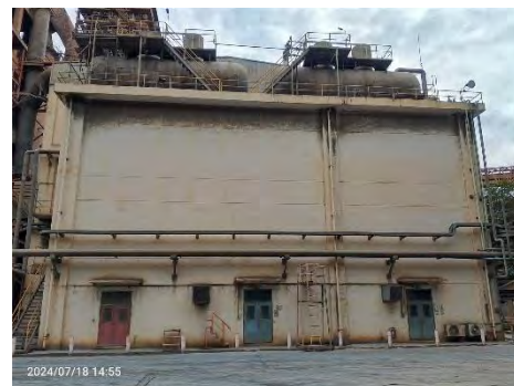
รูปที่ 2-32 อาคารปิดคลุมเครื่องจักรที่มีเสียงดังภายในพื้นที่โรงงาน 3 (สายการผลิตที่ 5 และ 6)
